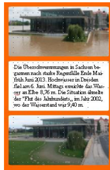
Abb. 72 Kongresszentrum in Dresden 2013 (vor und nach dem Hochwasser)
